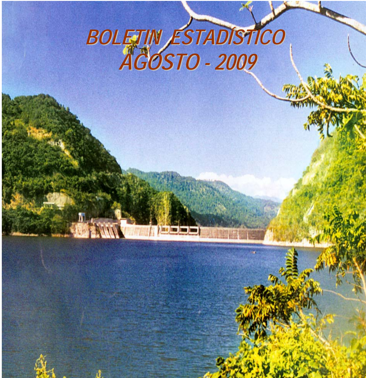
REPRESA HIDROÉLECTRICA FRANCISCO MORAZÁN (El cajón)
