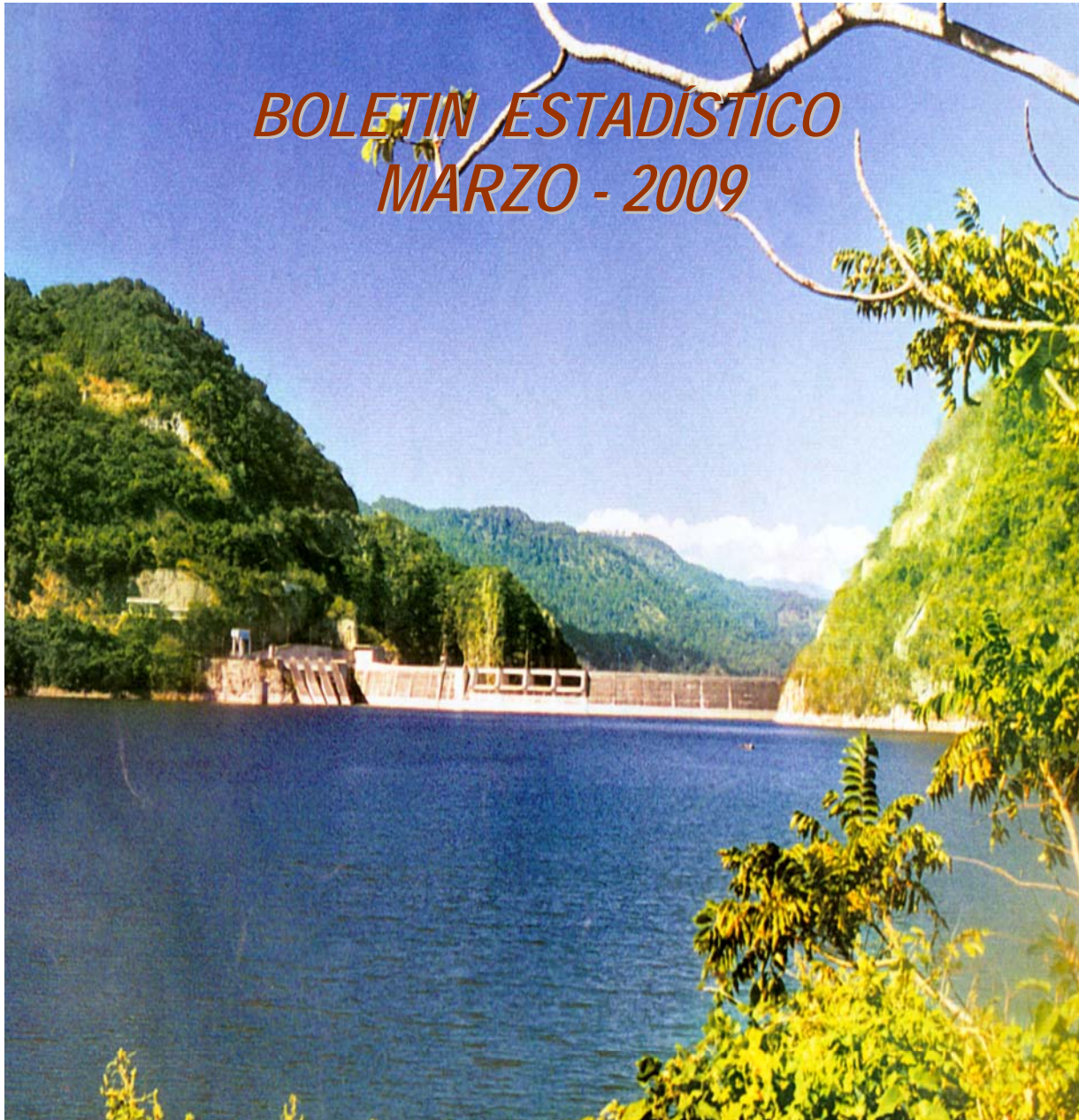
REPRESA HIDROÉLECTRICA FRANCISCO MORAZÁN (El cajón)
