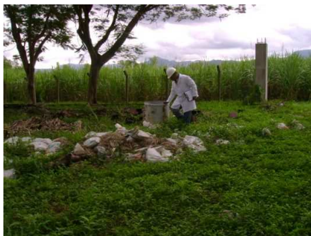
Imagen 6. Residuos sólidos y transformador vaciado y dispuesto en el suelo. Inventario Nacional de PCBs, PNI-COPs, Honduras 2008.
