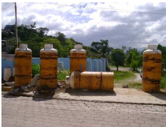
Imagen 4. Cilindros dispuestos a la intemperie conteniendo cloro gas. Inventario Nacional de PCBs, PNI-COPs, Honduras 2008.
