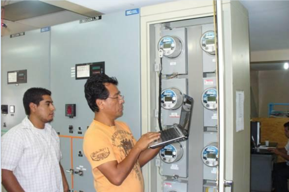
Elaborando Chequeo de competencia Sobre Modulo de descarga de medidores Nexus 1272 Luis Rodolfo Garcia y Alexander Portillo Corea
